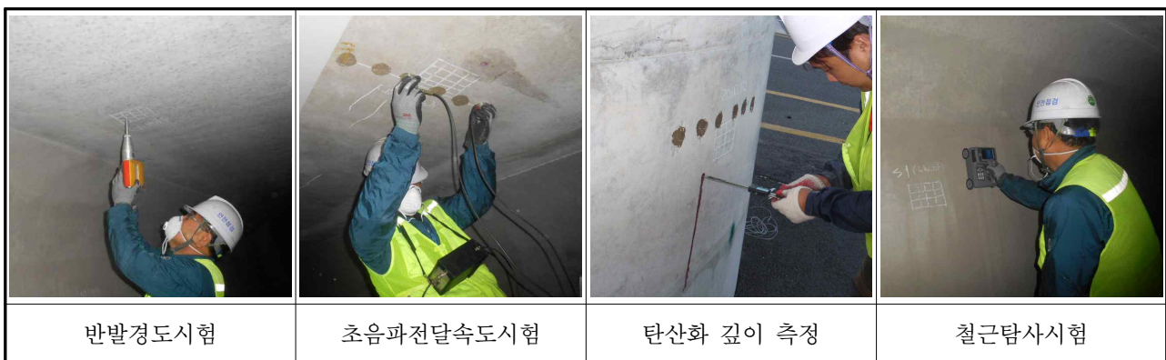
【사진 3.4.1】 콘크리트 내구성조사 전경
