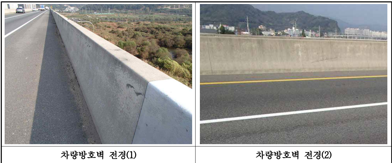
【사진 3.2.18】 방호벽 전경(대구)
