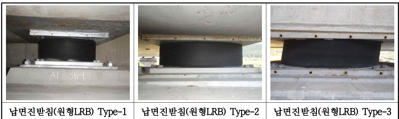
【사진 3.2.9】 교량받침 전경(대구)
