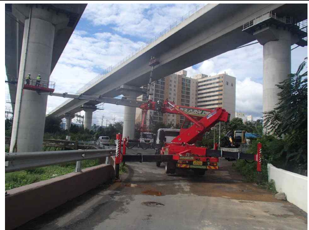
고소점검차를 이용한 조사
