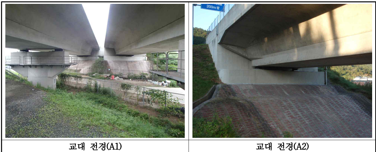
【사진 3.2.4】 교대 전경(대구)
