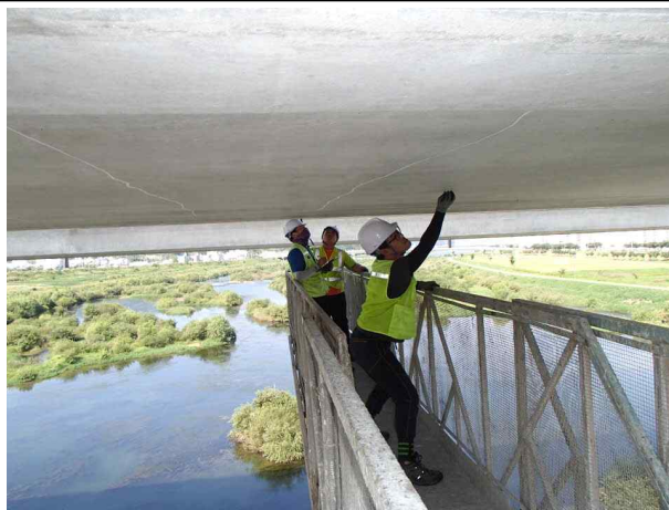
교량점검차를 이용한 조사
