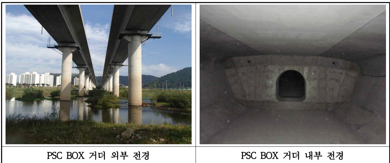
【사진 3.2.1】 PSC BOX거더 전경(대구)
