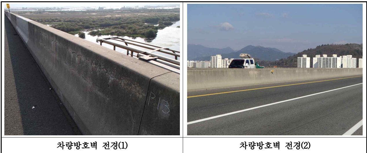
【사진 3.3.18】 방호벽 전경(부산)
