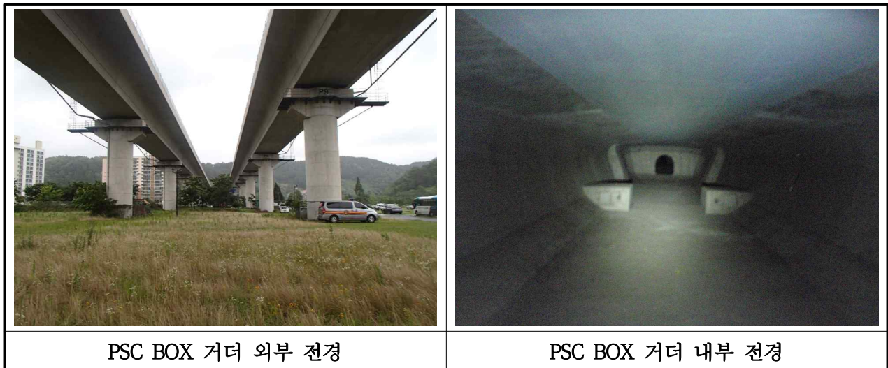
【사진 3.3.1】 PSC BOX 거더 전경(부산)
