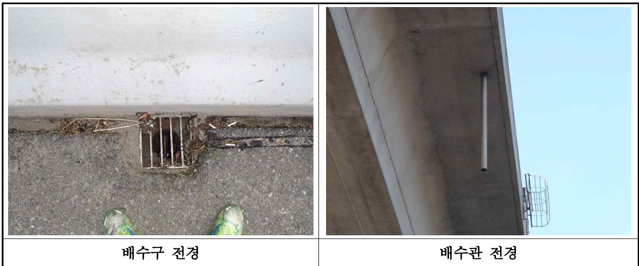
【사진 3.2.16】 배수구 및 배수관 전경(대구)
