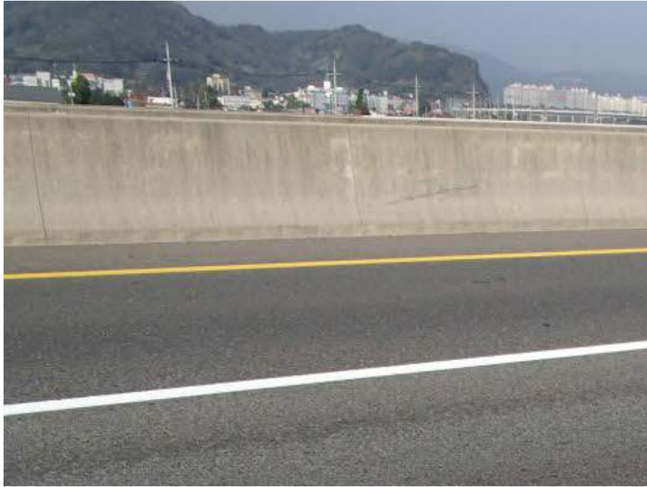
차량방호벽 전경 (1차로측)
