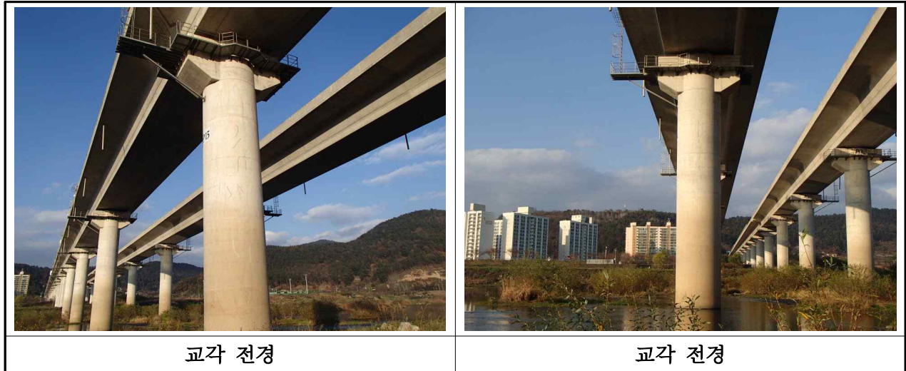
【사진 3.3.6】 교각 전경(부산)
