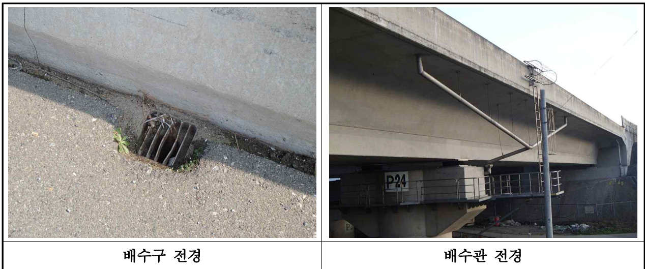
【사진 3.3.16】 배수구 및 배수관 전경(부산)
