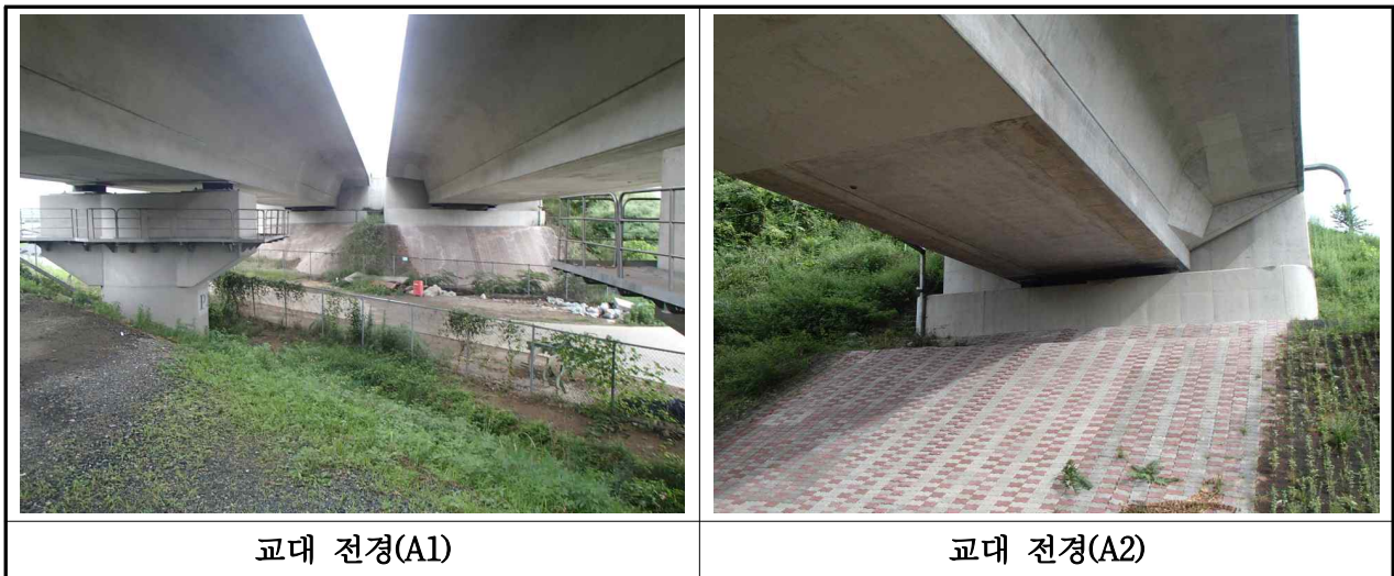
【사진 3.3.4】 교대 전경(부산)
