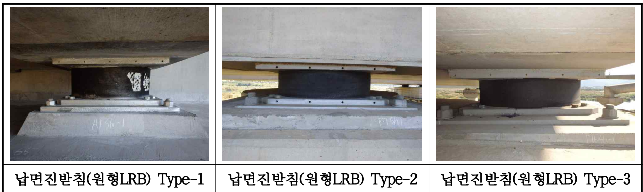
【사진 3.3.9】 교량받침 전경(부산)
