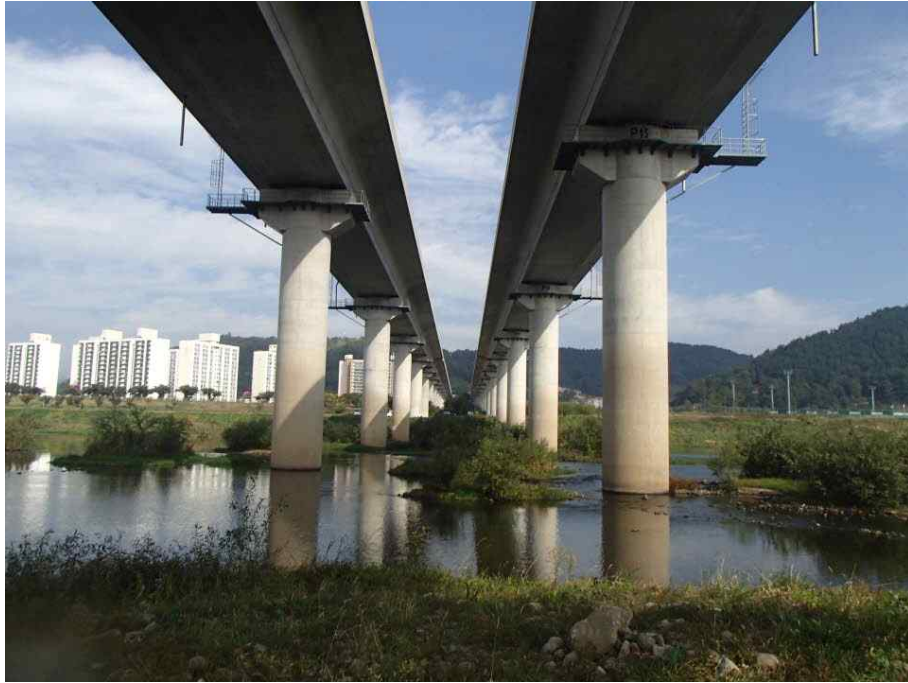
PSC BOX 외부 전경
