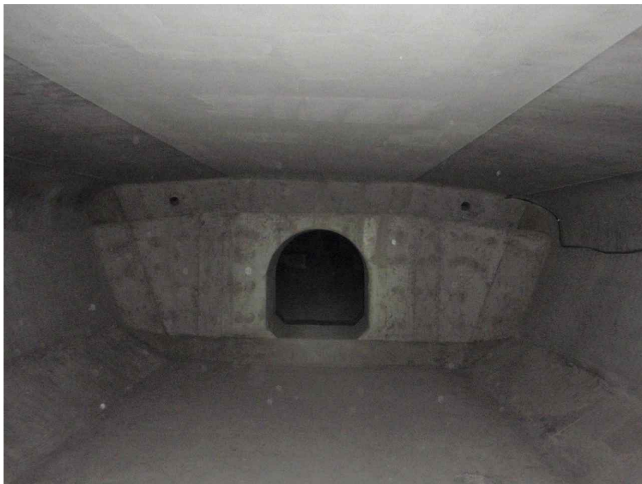
PSC BOX 내부 전경
